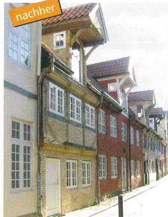
ligen Zeit eingesetzt worden sind. Beispiele: Die Flensburger Ziegelsteine sind mit hydraulischem Kalkmörtel wieder vermauert worden. Das Eichenholz für das Fachwerk wurde ohne Metallverbindungen zimmermannsgerecht aufgestellt. Die Steine der Gefache wurden mit Lehmörtel ausgemauert und mit Kalkmörtel nachverfugt. Der Dachstuhl wurde mit Seegras gedämmt, das massenhaft in Herbst an den Stränden liegt.
