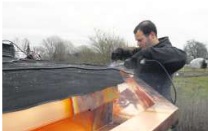
Das Artefact-Gebäude hat eine neue Dachhaut bekommen. Hier ist Marvin Lohrmann von Die Holzverbindung GmbH bei der Arbeit. Fotos: Kiwit
